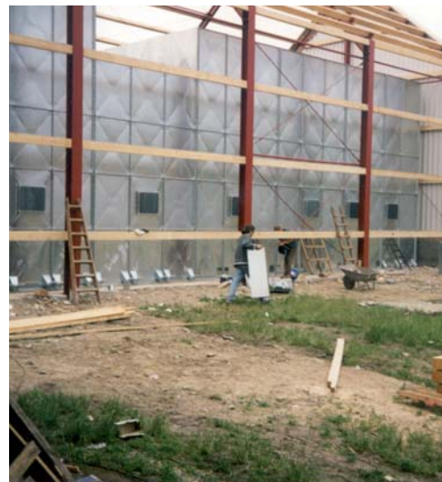
Montage d'un silo rectangulaire avec un sol fluide pour la vidange pneumatique
