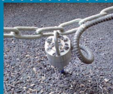
Sondes de température dans le silo
