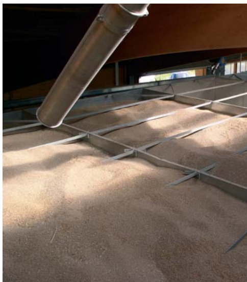
Silo de stockage rectangulaire, cellules remplies
