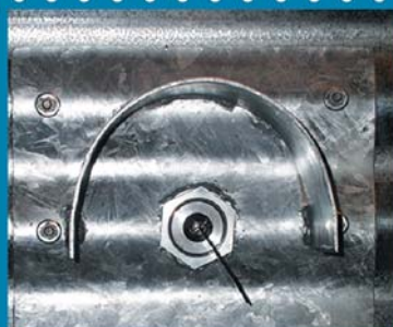
Détecteur de niveau à palette rotative
