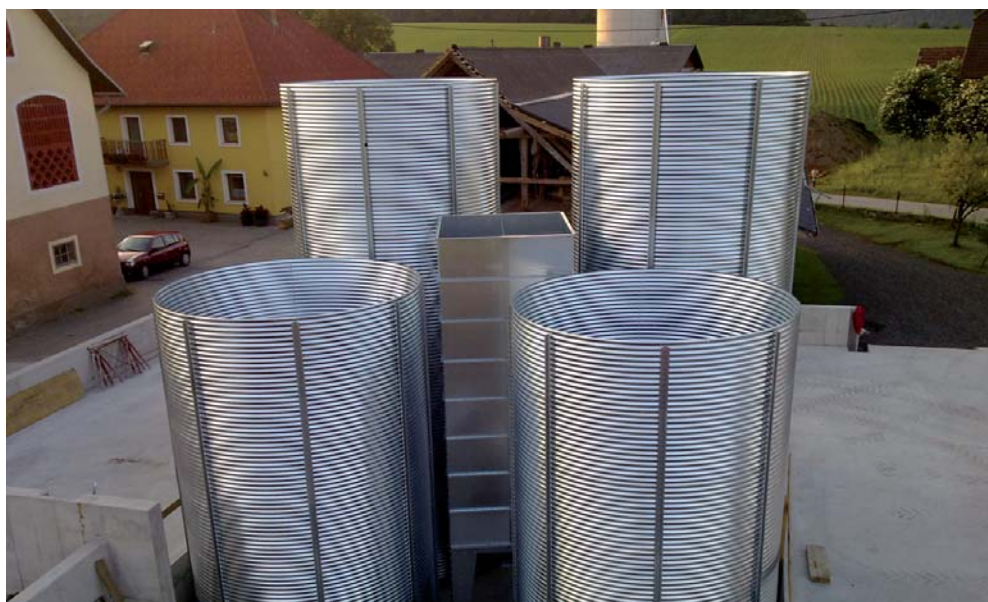
Silos ronds HIMEL en construction
