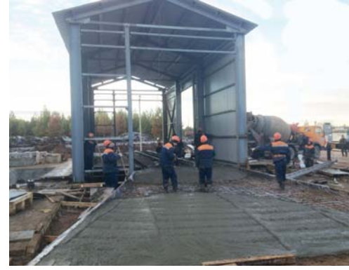
Travaux de bétonnage
